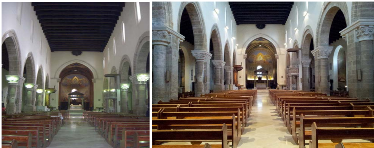
Navata centrale prima e dopo l'intervento.
